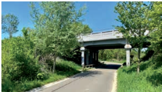
Viaduct Fommestraat, vanuit het zuiden. Ongelijke kruising met Rijksweg N278.
