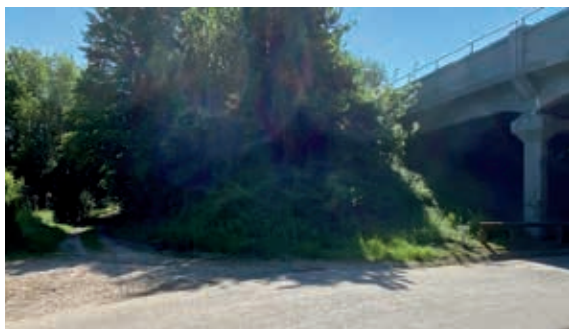
Noordzijde Viaduct Fommestraat. De veldweg, parallel aan de Rijksweg en links in beeld, loopt naar beneden af. Ca. 25 meter verder loopt een greppel naar links, naar een nog lagergelegen strook die vroeger een natuurlijke bufferfunctie had die kan worden hersteld.
